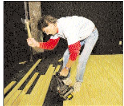
フローリングの長さは、任意に配置されません。パワーネーラーを使って、さねに隠し釘打ちで下地材に釘付けします。
