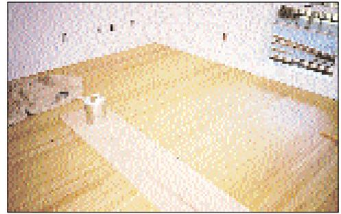
仕上げ中、できるだけ床との接触を避けるため、布などを敷いて作業してください。水分、汗、手垢、膝の跡などは、ステインやワックスの浸透を妨げます。
