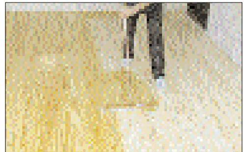
仕上げ剤は、ラムウールのパッドでフローリングと同じ方向に塗ります。75mm程重ねながら順々に施していきます。
