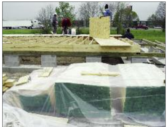
適當的作業現場儲存
