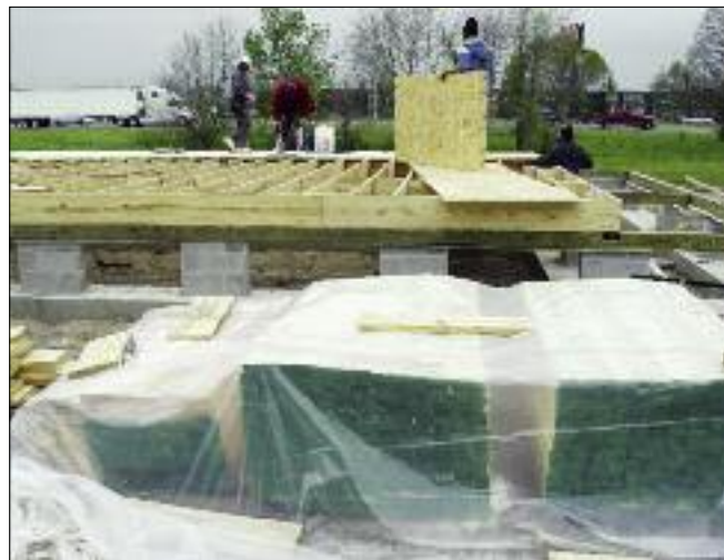
正确的作业现场储存
